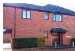
イギリス • IMV EUROPE LIMITED • Manufacturing and Demonstration Centre
