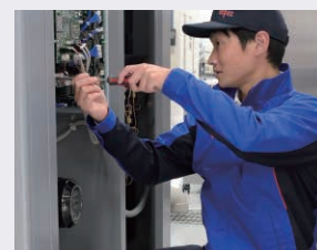
現地作業 (点検・修理)
