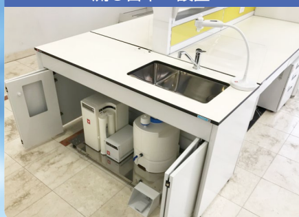
流し台下へ設置
