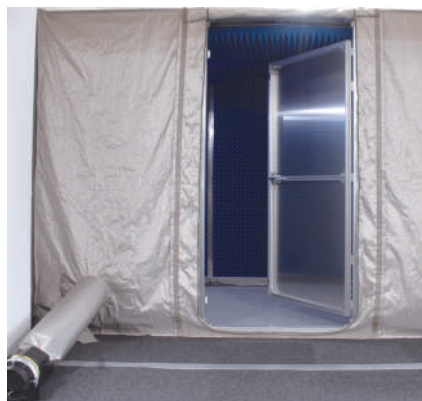
正面扉 取付時
